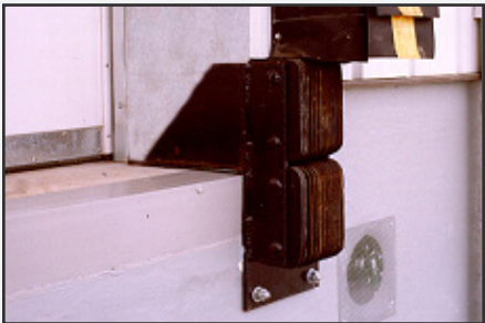
Parachoques laminados verticales con soporte con escuadra y placa de distribución de carga.
